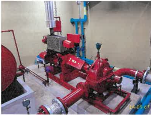
เครื่องสูบน้ำดับเพลิงชั้นใต้ดิน อาคาร A
