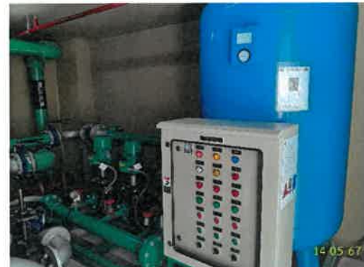
ปั๊มน้ำสำรองเพื่อการอุปโภค-บริโภค ชั้นตาดฟ้า อาคาร A
