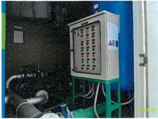
ปั้มน้ำสำรองเพื่อการอุปโภคและบริโภค ชั้นตาดฟ้า อาคาร B
